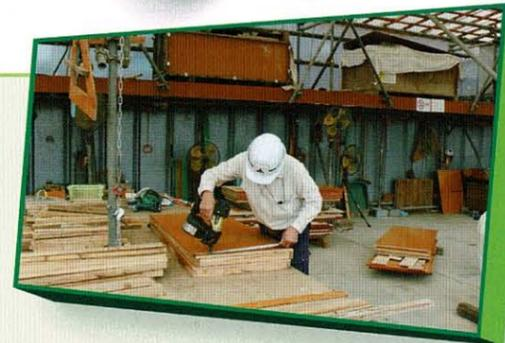
現場での作業に先立ち、加工場で型枠の加工や資材の用意などを行い、スムーズな現地工事に向け、準備万端整えます。
