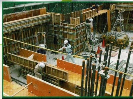
墨出しした印に合わせて型枠を建てています。型枠の建て込みの精度が建物全体の仕上がりを決定する大変重要な作業となります。
