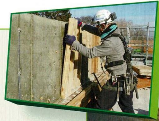
コンクリートが固まったら、組み立てた型枠を取り外します。
