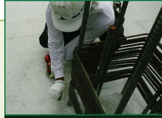
施工図をもとに柱や壁の位置や厚さを、「墨つぼ」を使ってコンクリート床面に正確に墨出しします。その後、型枠を建てる土台となる場所に栈木を敷いて高さを合わせていきます。
