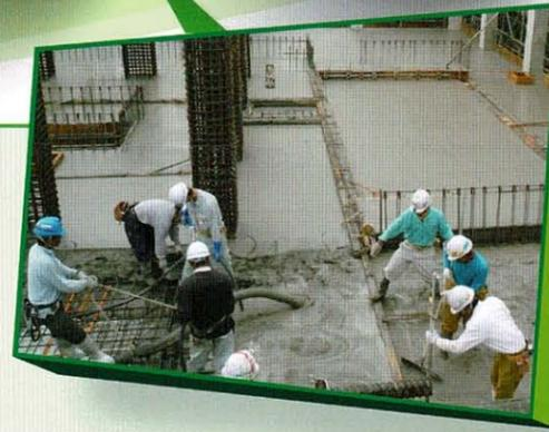
組み立てた型枠の中に生コンクリートを流し込みます。コンクリートの打設は別職種が行いますが、打設前と打設中の点検は型枠大工の仕事です。
